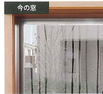
アルミ窓 (単板ガラス)
