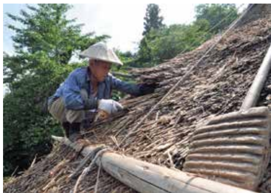
水口十一面観音堂のカヤ葺き屋根の手入れ
